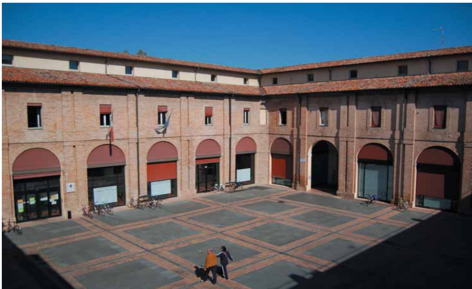
Restauro dell'ex convento di Santa Chiara e riutilizzo per uffici comunali; il disegno del cortile interno che, nelle partiture del pavimento, riprende la scansione delle lesene, fa assumere allo spazio l'immagine di una vera e propria piazza (Progetto: Fausto Cortini e Ennio Nonni - 1986).
